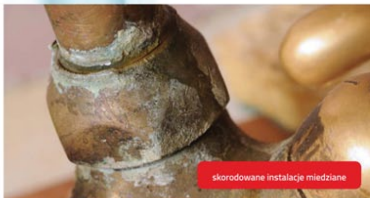
osad i korozja na zlewie
